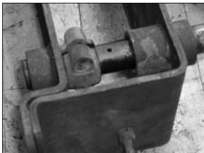
3. Hullet boret fra bagsiden.
