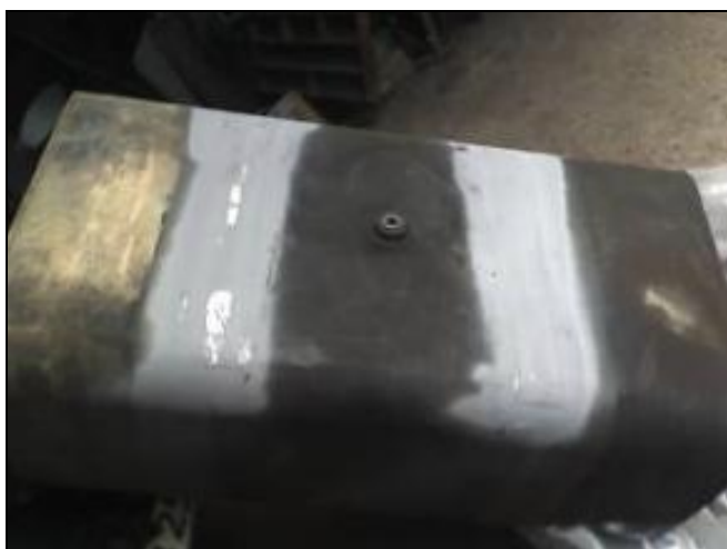
Fig. 8 - Tanken lappet med 2 strimler rustfri stål.
